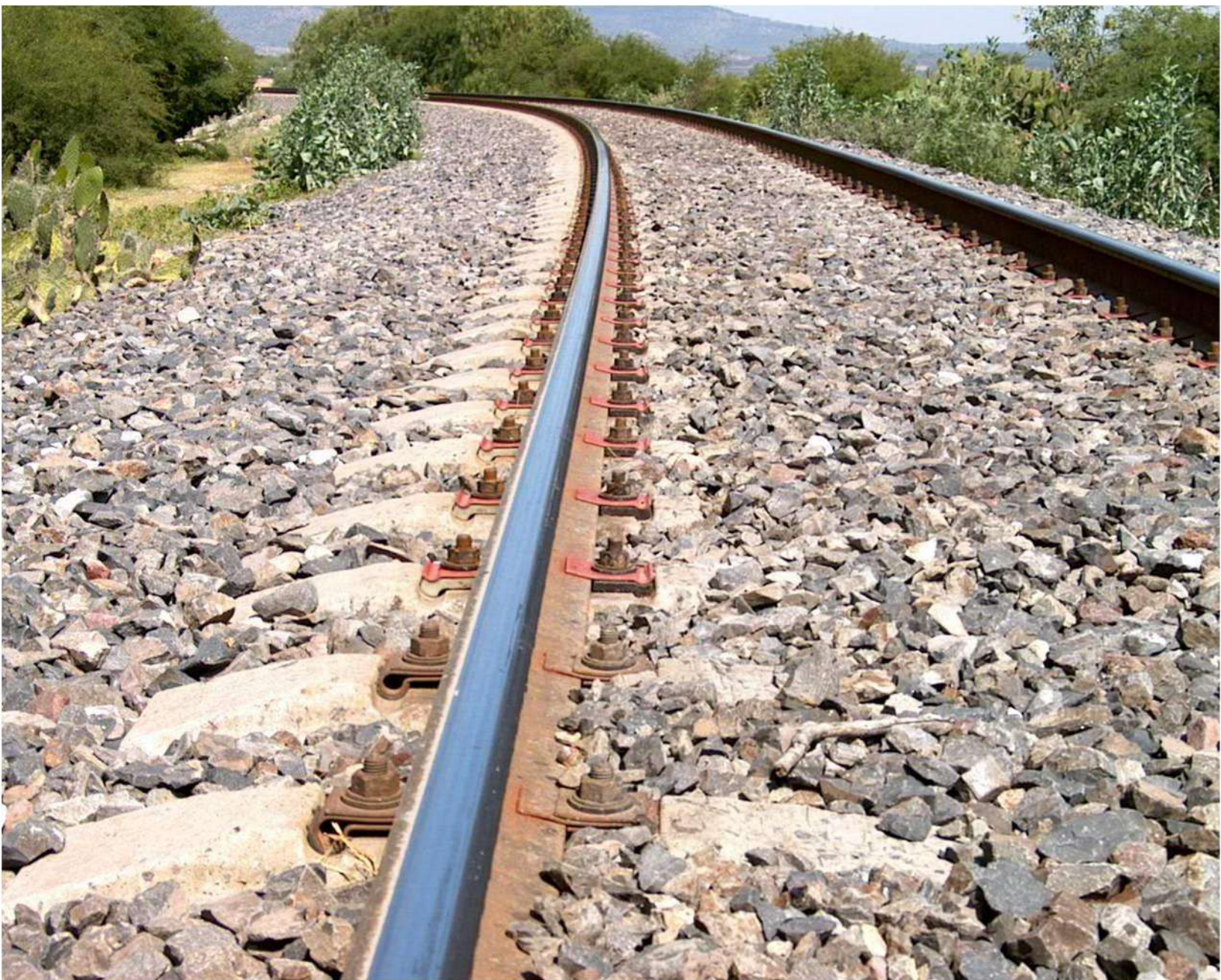
Curva izquierda de 4°. Instalación de sistema de fijación elástica NY-ES en Km B97 [28-Feb-07].
