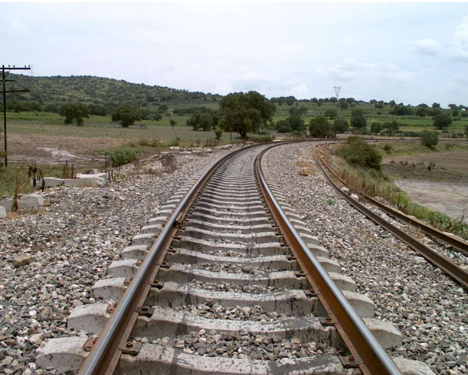
Curva derecha de 5°. Instalación de sistema de fijación elástica NY-GN en Km B59 [01-Mar-05].
